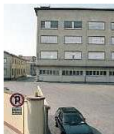
PENSONI E RISARCIMENTI La Zignago di Fossalta
